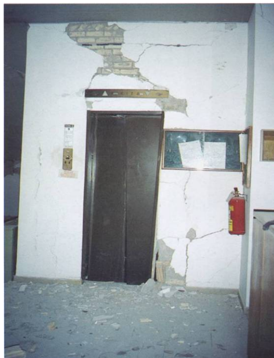
Εικ 3.14. Αίγιο, σεισμός 1995. Ο ανελκυστήρας είχε πάθει βλάβες. Η χρήση του μπορούσε να προκαλέσει τον εγκλωβισμό ατόμων.
